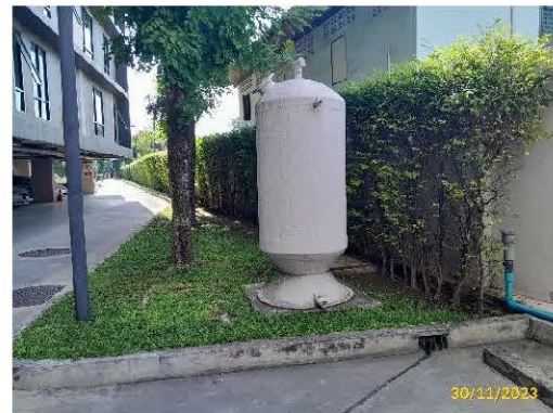
ระบบกำจัด Aerosol และระบบกำจัดมีเทน อาคาร C
