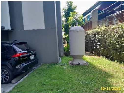
ระบบกำจัด Aerosol และระบบกำจัดมีเทน อาคาร C
